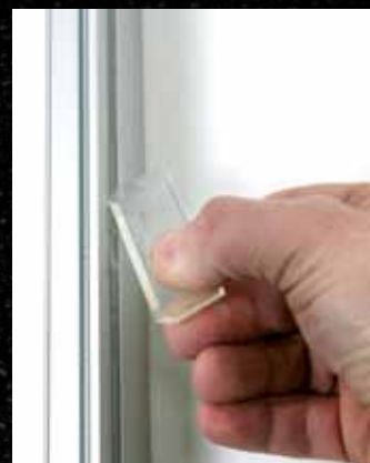
12 Um eine saubere Kante zu erhalten, empfehlen wir das Silikon mit einem so genannten Fugenboy abziehen.
