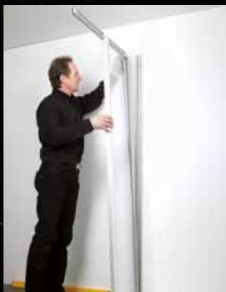
5 Das vormontierte Segment wird einfach in die Wandleiste eingeschoben...
