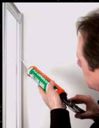
11 Ein neuartiger Silikonkanal zwischen Wandleiste und Verstellleiste verbindet beide Elemente dauerhaft sicher und dicht und lässt die Versiegelungen ohne Verschmieren zum Kinderspiel werden.
