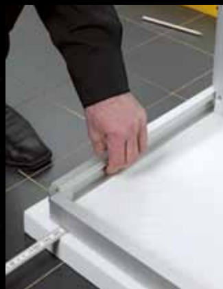
7 Anschließend wird das untere Rahmenprofil parallel zum Wannenrand ausgerichtet...
