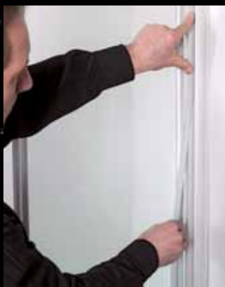
9 Durch Eindrücken einer Kederleiste wird die Duschabtrennung sicher und fest in der Wand fixiert.
