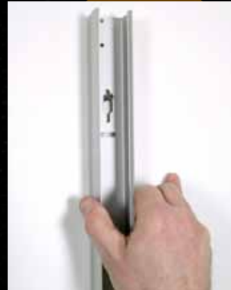
4 Im nächsten Schritt werden die Wandleisten in die dafür vorgesehenen Schrauben eingehängt und fest an der Wand verschraubt.
