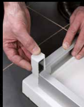
8 ... und die Eckkappen aufgesteckt.
