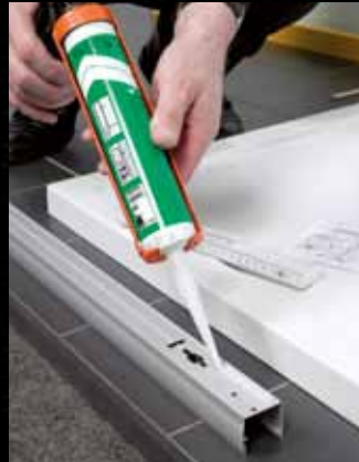
3 Für eine optimale Abdichtung werden die Wandleisten rückseitig mit einem Silikonanstrich versehen.
