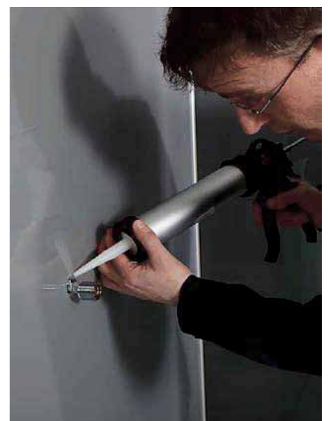
3.20 Durchführungen mit essigsäurefrei vernetzendem Naturstein-Silikon abdichten
