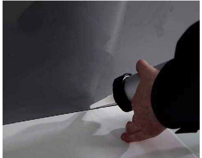
3.22 Bodenbereich mit essigsäurefrei vernetzendem Naturstein-Silikon abdichten. Das Silikon 24h aushärten lassen.
