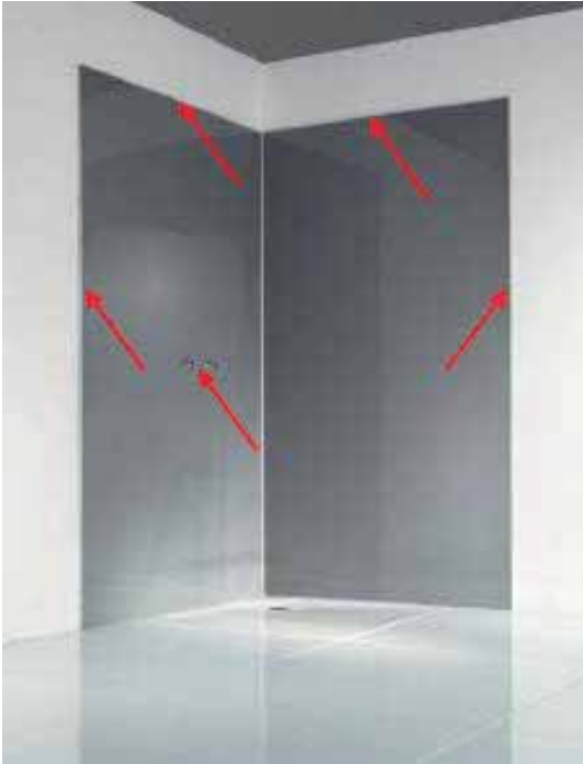
3.21 Designplatten rundum zur Wand hin mit essigsäurefrei vernetzendem Naturstein-Silikon abdichten.
