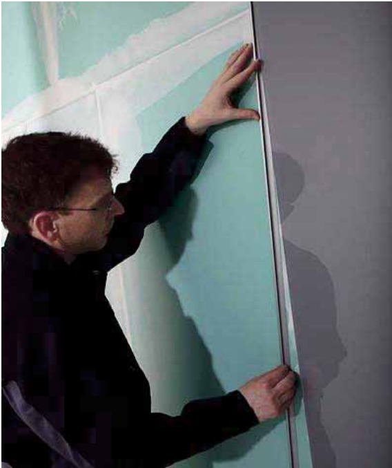
3.17 Das Abschlussprofil (ebenfalls mit einer dünnen Linie auf der Flanke silikonieren) kann vor oder unmittelbar nach dem Anbringen der Platte aufgesetzt werden.
